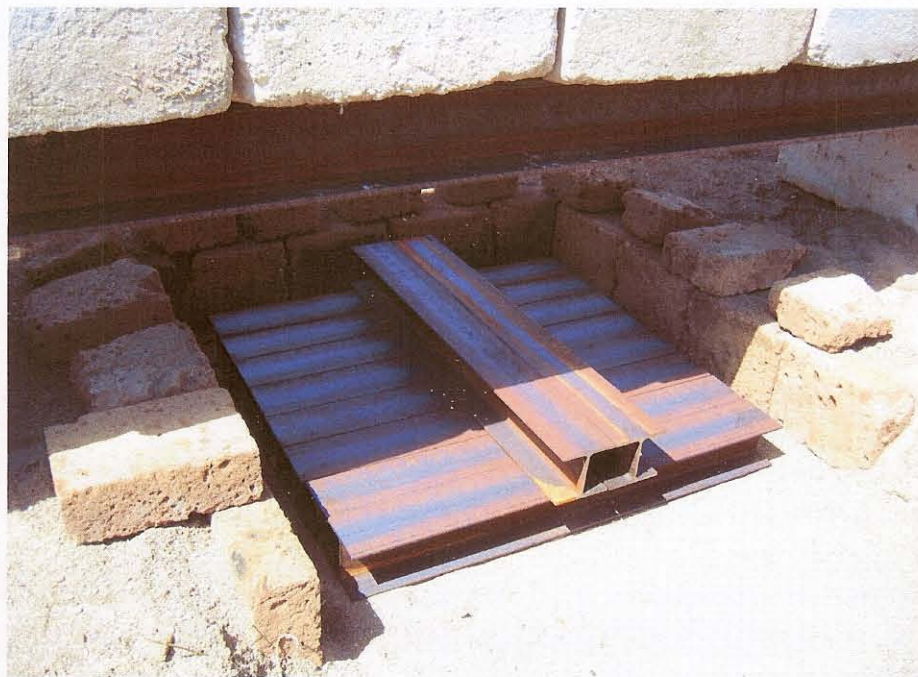
Fotografia delle putrelle posizionate in corrispondenza della botola del serbatoio.
